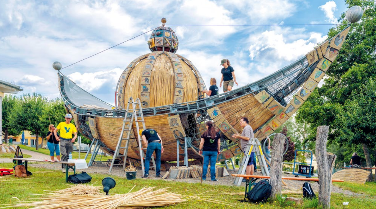
Die Verkleidung der Arche mit Schilf wurde im Zuge der Restaurierung vollständig erneuert. Diese Aufgabe übernahmen Mitarbeiter der Sage Bäurer GmbH aus Donaueschingen. Strahlend präsentiert sich die mit frischem Goldlack versehene Kuppel (rechts unten).
